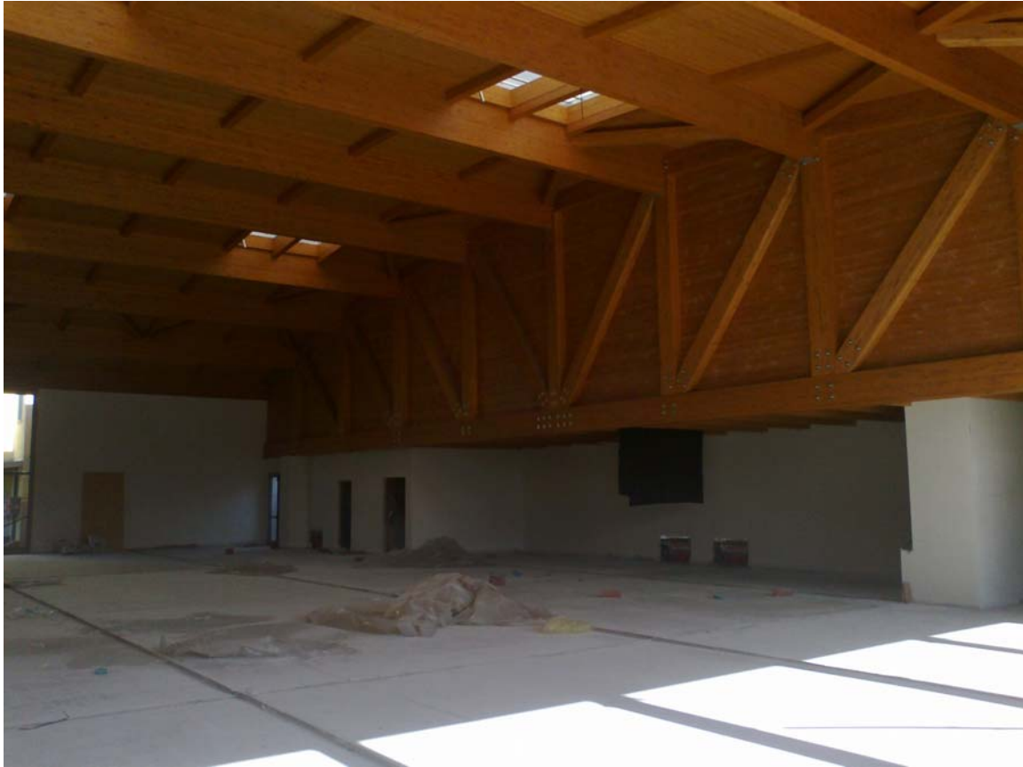
VISTE INTERNE PALESTRA-PARTICOLARE TRAVE RETICOLARE LATO SUD
