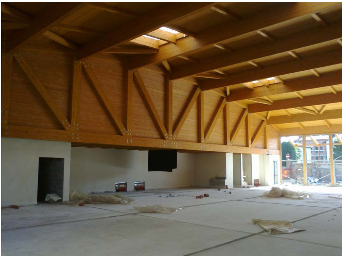
VISTE INTERNE PALESTRA-PARTICOLARE TRAVE RETICOLARE LATO SUD
