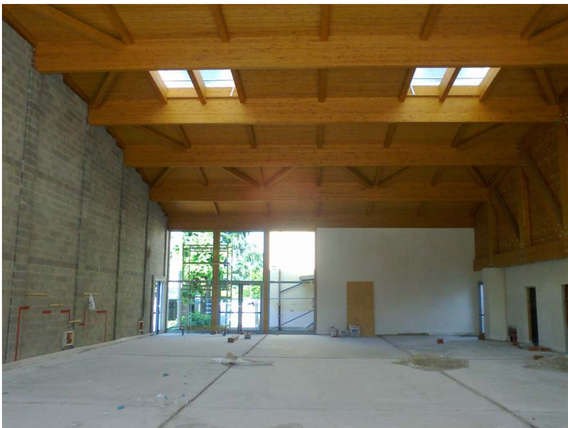
VISTE INTERNE PALESTRA-PARTICOLARE TRAVI DI COPERTURA LATO OVEST
