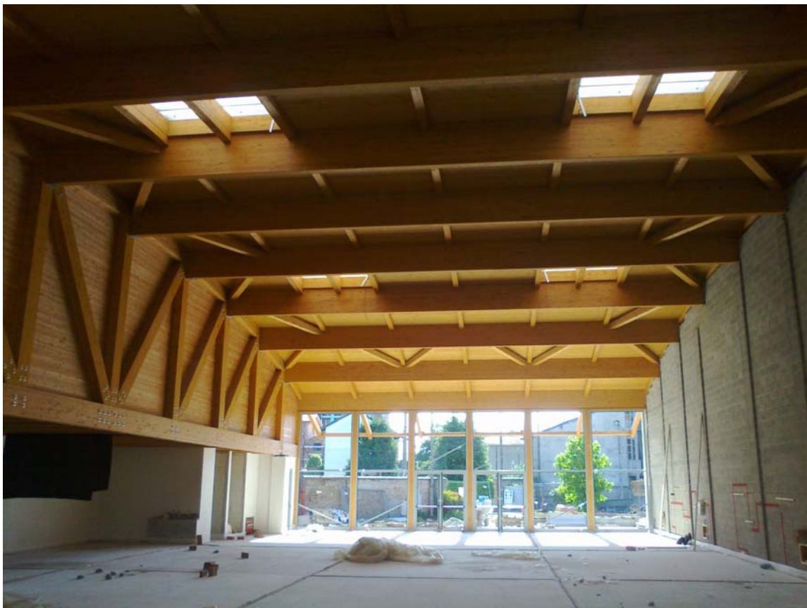
VISTE INTERNE PALESTRA-PARTICOLARE TRAVI DI COPERTURA LATO EST
